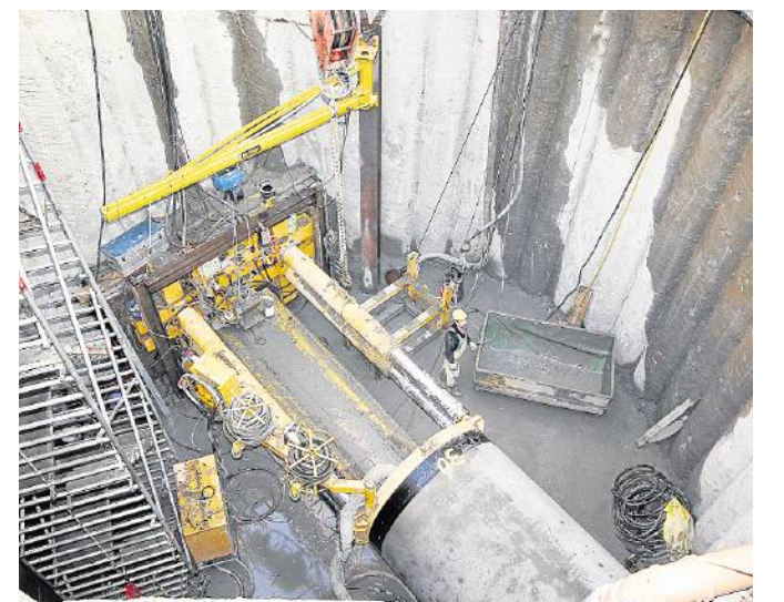
Die Abwasserbeseitigung in Bergkamen ist teuer, unter anderem weil die Kanalrohre wegen des Bergbaus oft erneuert werden mussten. Die CDU fordert, die kalkulatorischen Zinsen des Stadtbetriebs Entwässerung (SEB) zu senken, um die Abwassergebühren noch weiter als geplant zu verringern. Foto: Archiv
